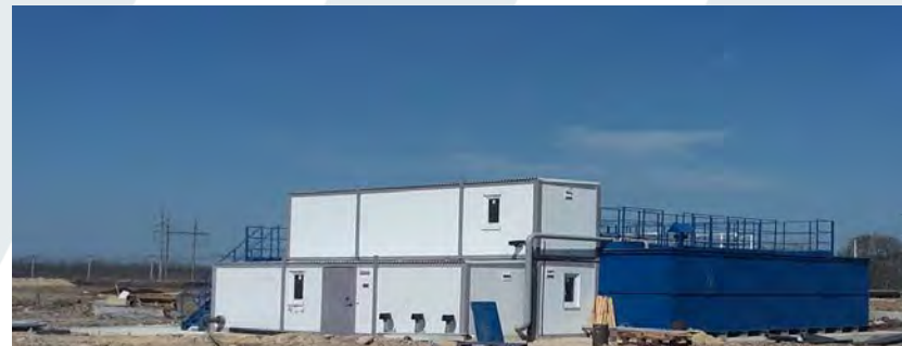
Ставропольский край, г. Михайловск Очистные сооружения хозяйственно бытовых сточных вод. Поставка, шефмонтажные работы . Производительность 160 м 3 /сут.
