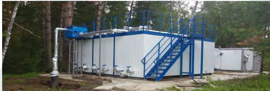
г. Томск, Зеленый мыс. Мембранный биореактор Строительно-монтажные, пуско-наладочные работы. Производительность 300 м 3 /сут.
