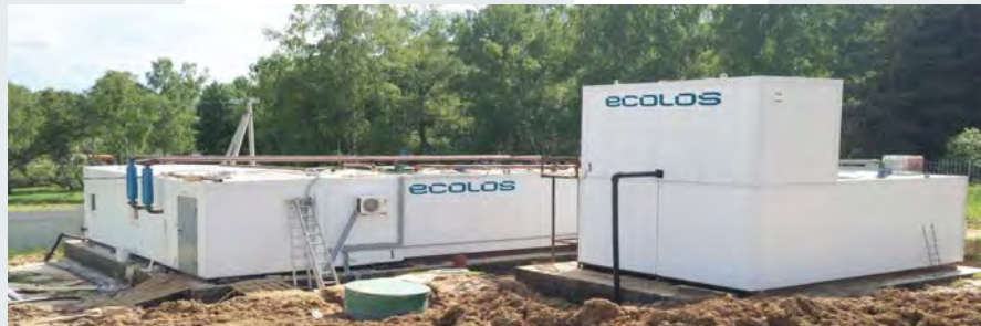
п. Сиеста, Ленинградская область . Мембранный биореактор. Строительно-монтажные, пуско-наладочные работы. Производительность 225 м 3 /сут.
