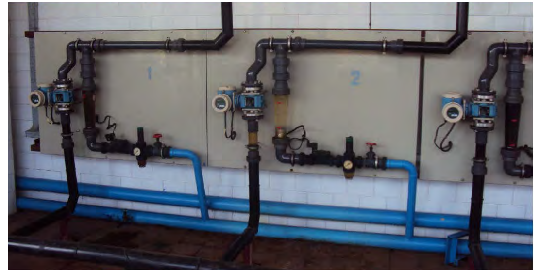
Promag W DN150. Ростов-на-Дону. 10 лет успешной эксплуатации
